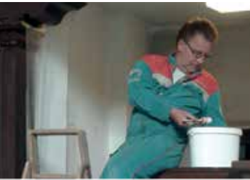
Bauen in Kirche Möckern
